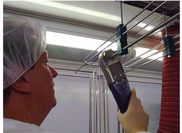
Abb. 7 Orbitalschweissen von Gasrohren
