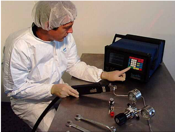
Abb. 6 Vorbereitung zum Orbitalschweissen von Gasrohren
