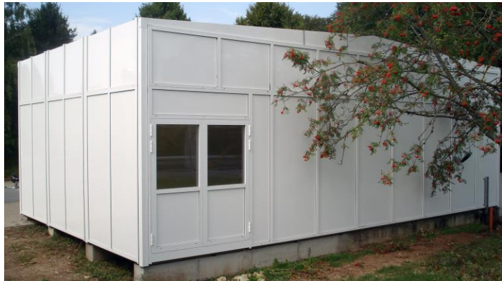
Reinraum Container ISO 7 90m 2 bestehend aus 3 Einheiten à 2,5m x 12m
