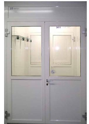
Fig. 3 Cleanroom double door
